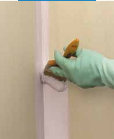
Verarbeitung von Mapegum WPS mittels Pinsel
