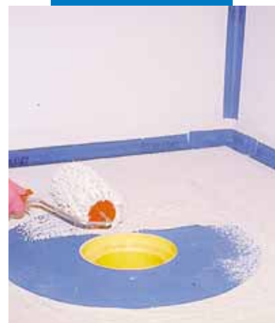
Eindichten der Dichtmanschette mit Mapegum WPS
