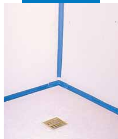
Die fertige Verbundabdichtung mit Mapegum WPS und Mapeband
