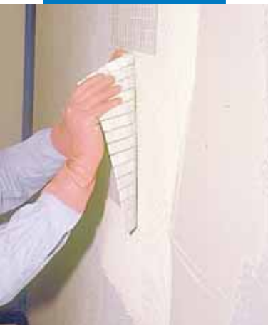
Ansetzen von Glasmosaik
